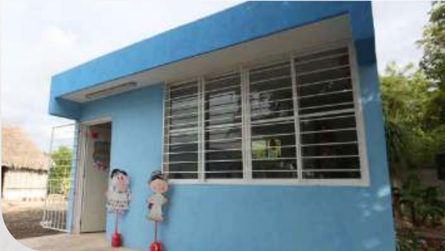
Construcción de Aulas de Educación Inicial Indígena
