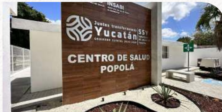
Rehabilitación de Centro de Salud de Popolá
