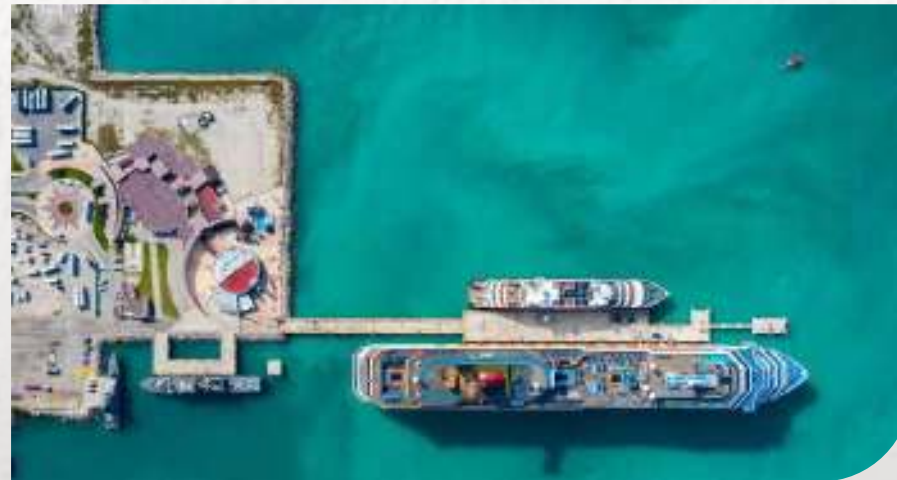
Ampliación del Puerto de Altura de Progreso
