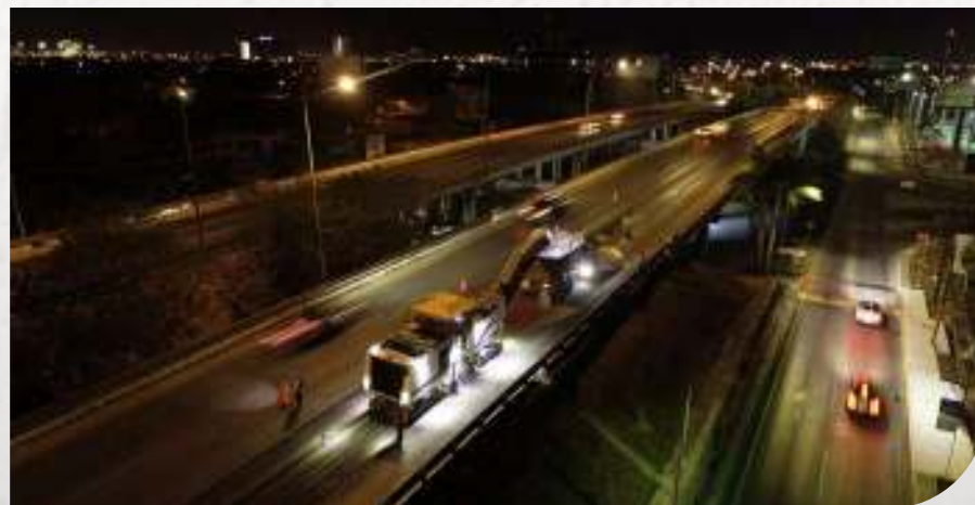
Trabajos de repavimentación del Anillo Periférico
