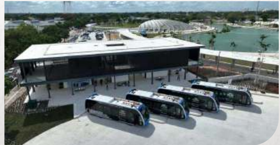
Unidades del IE-TRAM durante la supervisión de la estación La Plancha
