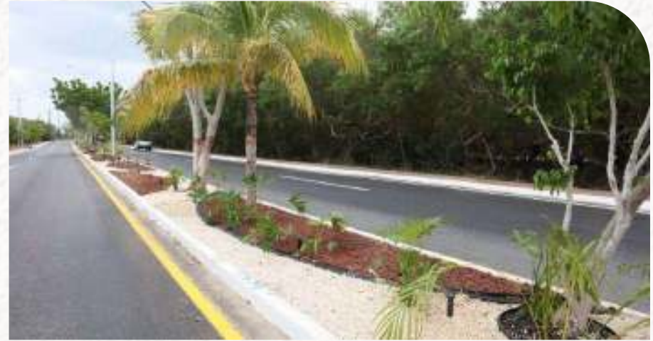
Rehabilitación carretera Progreso-Chicxulub
