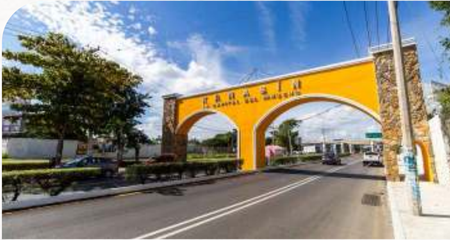
Mejoramiento de calles en el municipio de Kanásin
