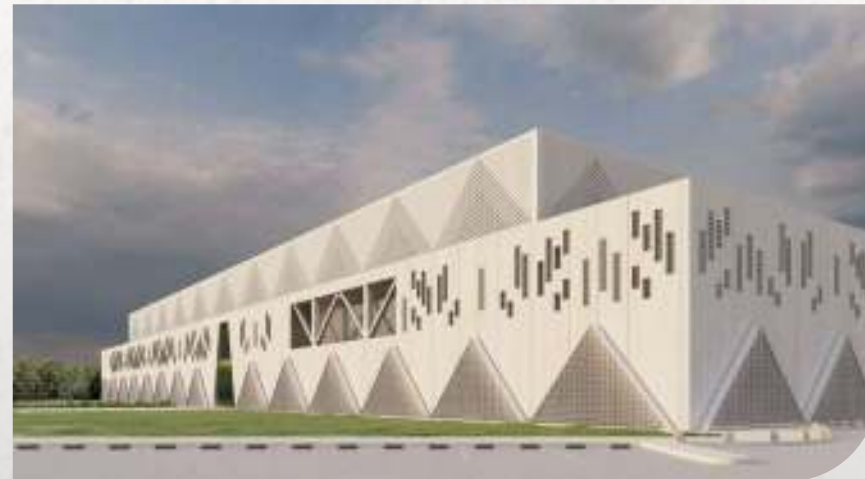
Hospital de Ticul en construcción
