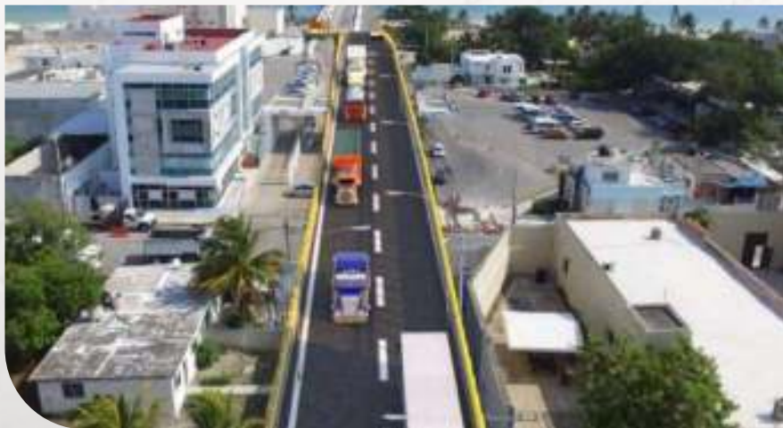
Viaducto elevado de Progreso
