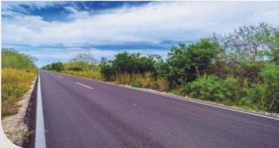
Construcción de nuevas calles en el municipio de Mérida
