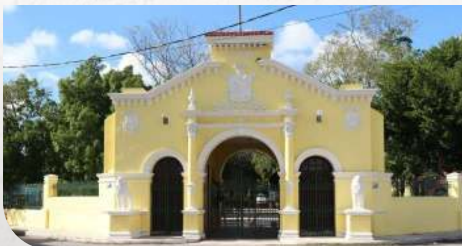
Rehabilitación del Centro Cultural La Ibérica
