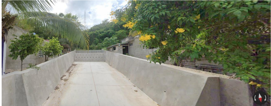
Ilustración 36.- Obras de mitigación en el municipio de Tekax.
